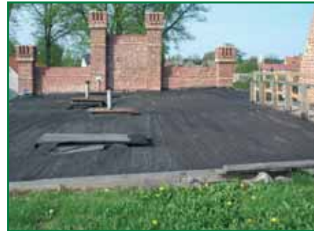
Bedachung über dem ehemaligen Eiskeller
